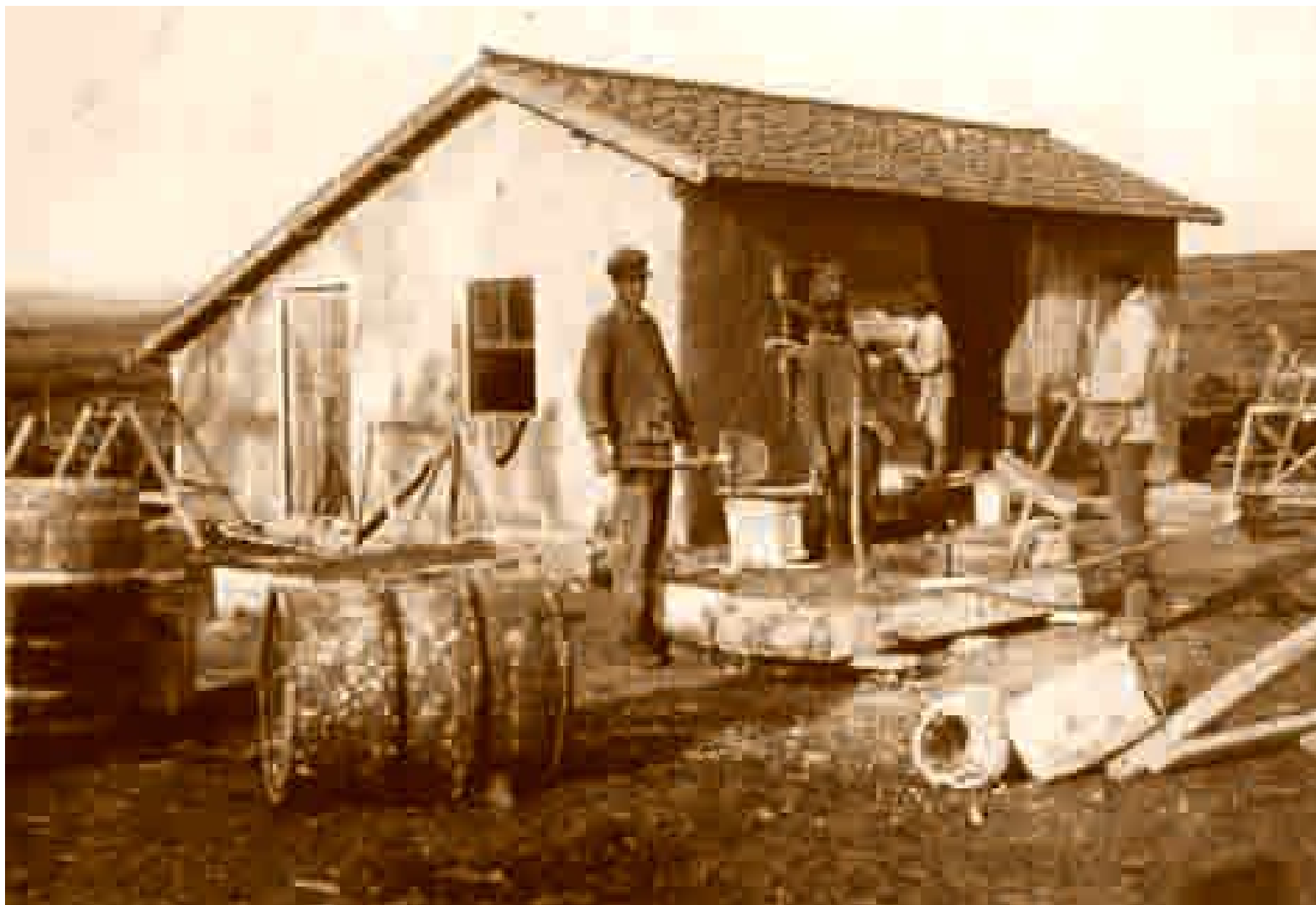
Κατασκευή σπιτιού για πρόσφυγες στη δυτική Θράκη (1925).
