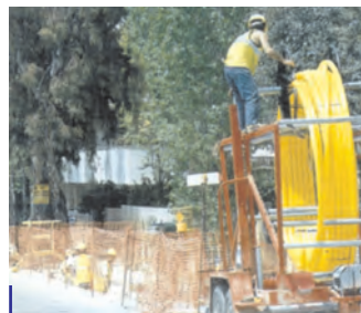
Τοποθέτηση αγωγού φυσικού αερίου
