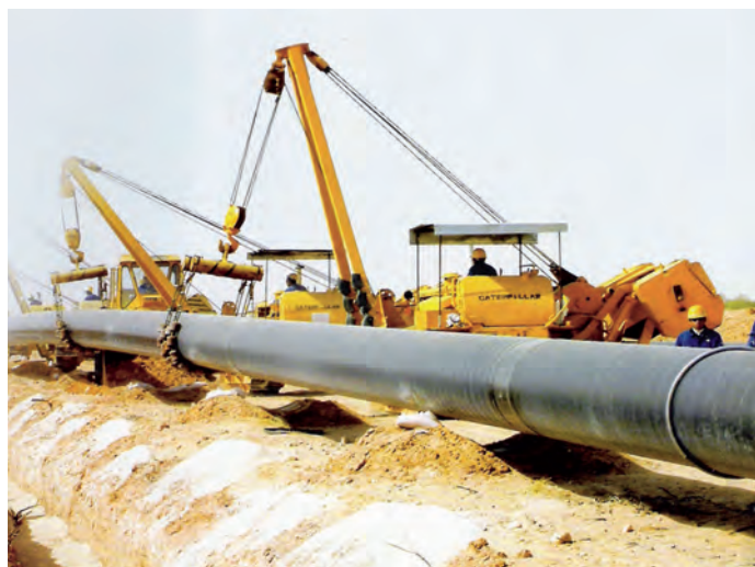
42.10 Κατασκευή αγωγού φυσικού αερίου
