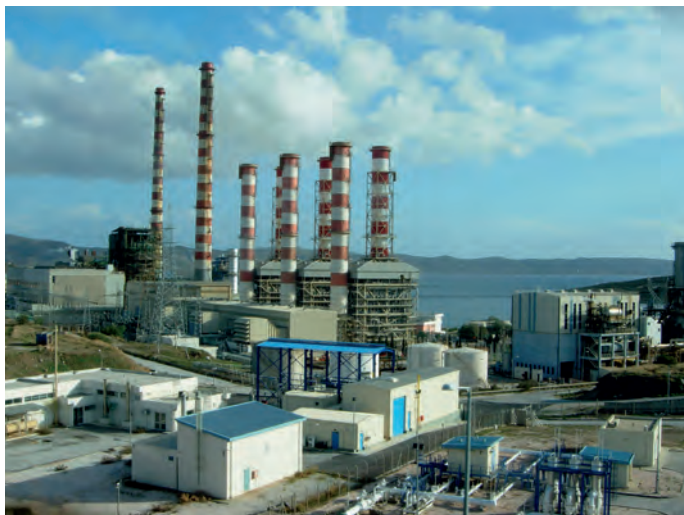
42.7 Λαύριο: θερμοηλεκτρικός σταθμός Δ.Ε.Η.
