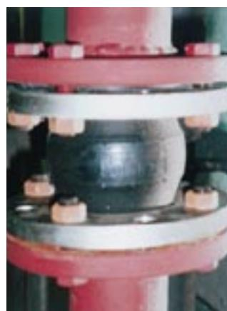
**Σχήμα 6-35:** Αντικραδασμικός σύνδεσμος από καουτσούκ,
