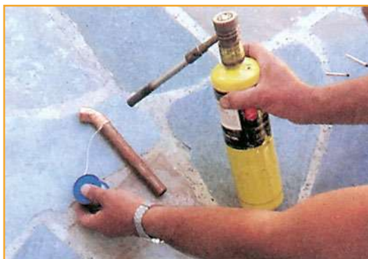
Εικόνα 7.7 Συγκόλληση χαλκοσωλήνα
