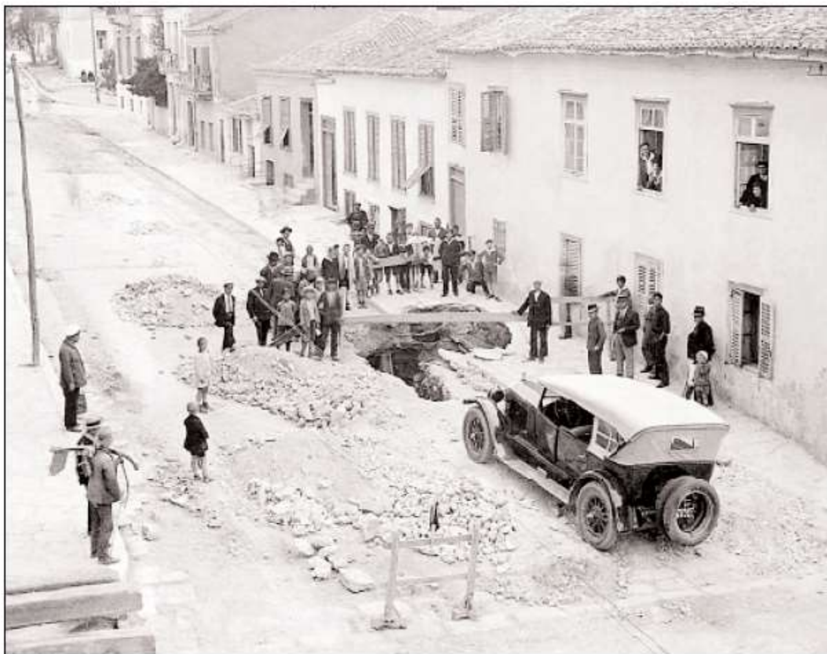
◀ Επισκευή αγωγού εντός της πόλεως, το 1930, υπό τα όμματα περιούκων και περαστικών. Παρατηρούμε και τις κοινωνικές διακρίσεις, όπως εκφράζονται μέσω του καπέλου: φαθάκι, ρεπούμπλικα, τηλέκιο, ιραγιάσκα. Σε πρώτο πλάνο ο «σανιζάρης» (αντός που ξύνει το βαμβάκι) και αντικίνητο, τελευταίο μοντέλο (φωτ.: Αρχείο ΕΥΔΑΠ).
