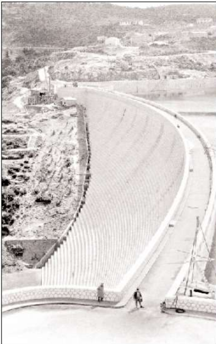
▲ Το φράγμα των Μαραθώνων, το μόνο στον κόσμο επενδυμένο με μάρμαρο, και μάλιστα πεντελικό, τον καιρό της αποπεράτωσης του. Κατασκευάστηκε από την αμερικανική εταιρεία Όυλεν το διάστημα 1925-1931 (φωτ.: Αρχείο ΕΥΔΑΠ).
