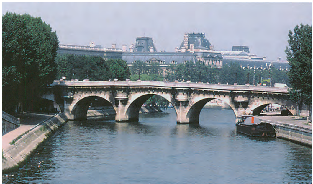
Εικόνα 5.8 Γέφυρα Μ. Αλεξάνδρου στο Σικουάνα
