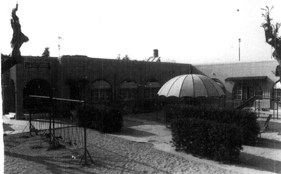
Ο Α' Παιδικός Σταθμός στην οδό Χ. Δασκαλάκη
