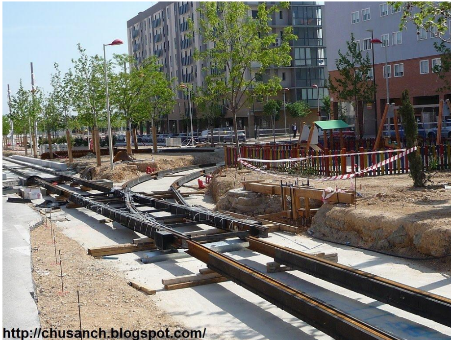
Εικόνα 16: Διεργασίες κατασκευής του τραμστην Βαλντεσπαρτέρα
