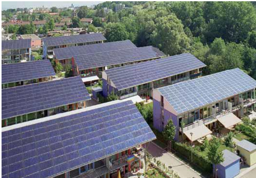
Εικόνα 1: Βάουμπαν, ένας πρώην στρατώνας άνοιξε τον δρόμο για την προώθηση των ηλιακών συλλεκτών
