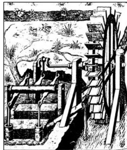
Φτερωτή νερόμυλου για τη εκμετάλλευση της ενέργειας του νερού
