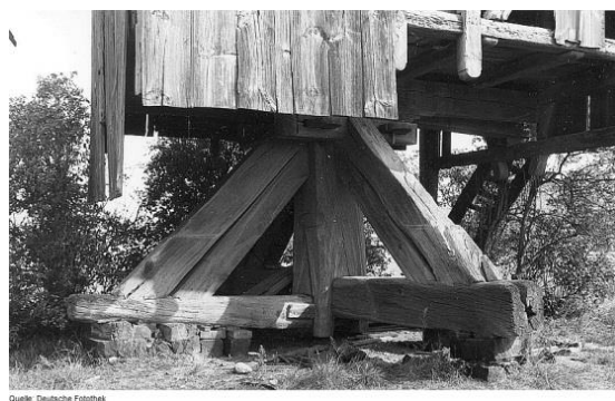
Στήριξη ανεμόμυλου τύπου στύλου
