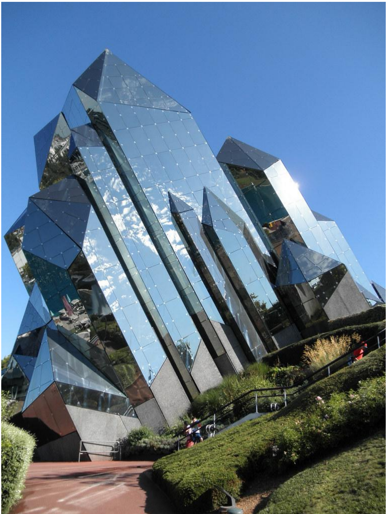
Το κτίριο «ΣΙΝΕΜΑΧ» στη Γαλλία 1990
