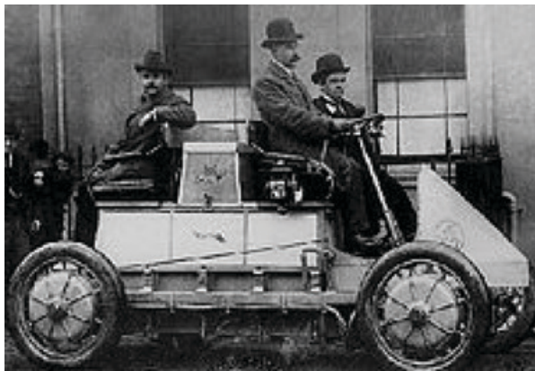
Εικόνα 1.1: Το Lohner-Porsche M9te Hybrid ήταν ένα από τα πρώτα αξιόλογα, από τεχνολογικής πλευράς, υβριδικά βενζινοκίνητα-ηλεκτροκίνητα αυτοκίνητα.
