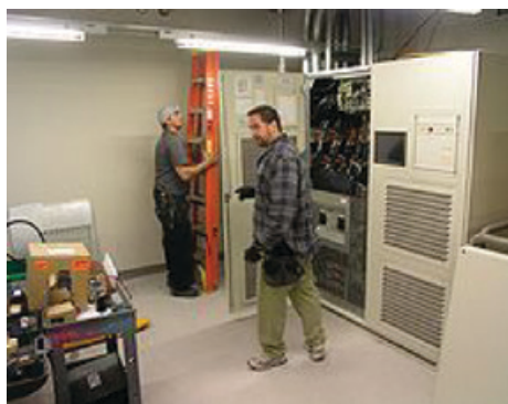
Σχήμα 3.7: Χρήση αντιστροφένων για την παροχή Ε.Ρ σε Η/Υ ή και σε κτίρια.
